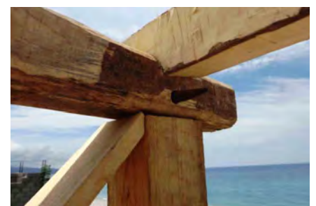
Assemblages traditionnels d'éléments en bois : tenon-mortaise avec cheville, liaison à tiers bois.
