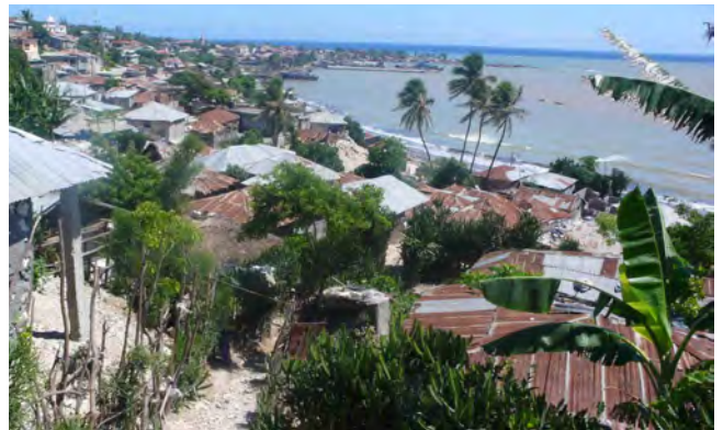
Ville de Jérémie, en bord de mer : toitures en tôle présentant des graves problèmes de dégradation- rouille.
