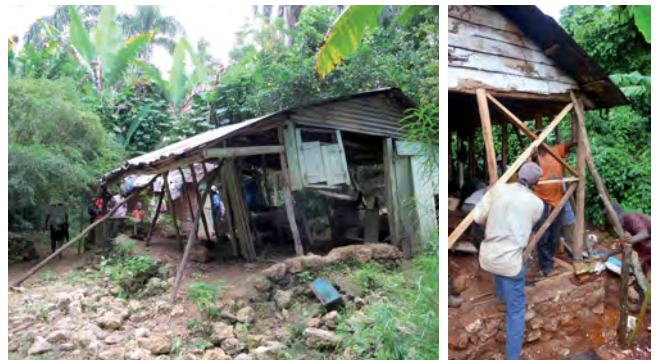
Reconstruction réutilisant les matériaux récupérés.
