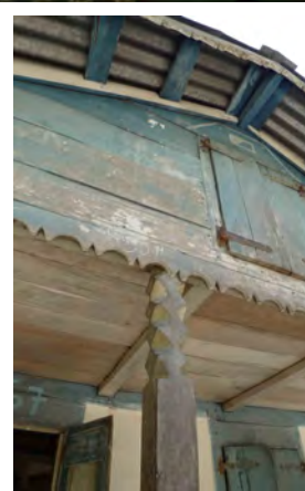
Planches de rive, dont la forme découpée réduit la pression du vent dans la galerie et en dessous de la toiture.
