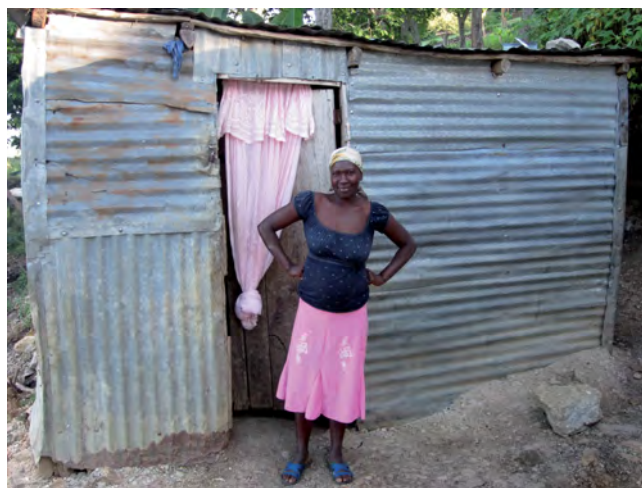
Utilisation de matériaux locaux et/ou de récupération : bois pour la charpente et tôles métalliques pour les murs et toiture.
