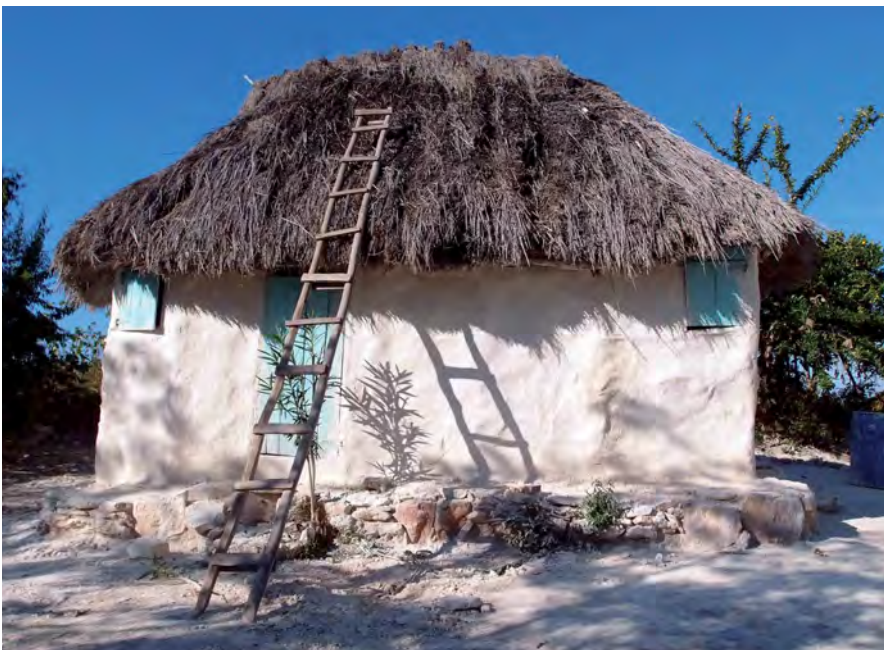
Maison avec toiture à 4 pans bâtie sur une masse de protection.
