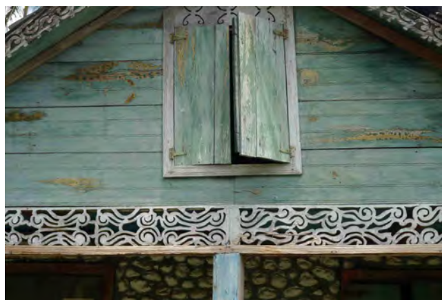
Planches de rive, dont la forme découpée réduit la pression du vent dans la galerie et en dessous de la toiture.
