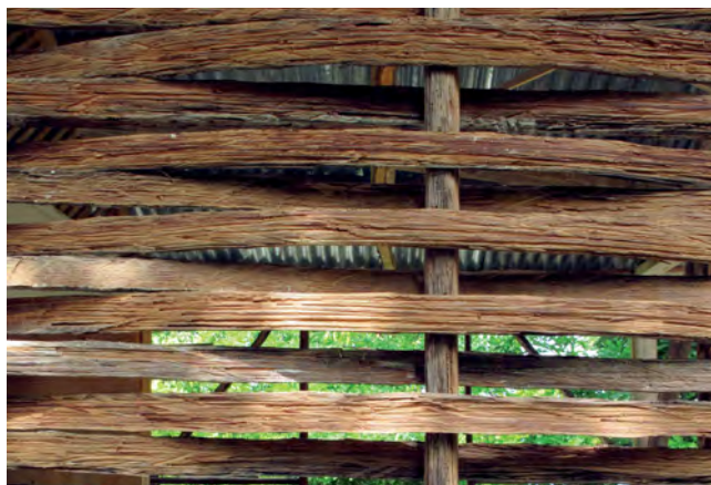
Le lattes pour le clissage est très perméable à l'air, permettant une bonne ventilation. Toutefois, cela n'empêche pas l'entrée d'insectes et autres petits animaux dans la maison.
