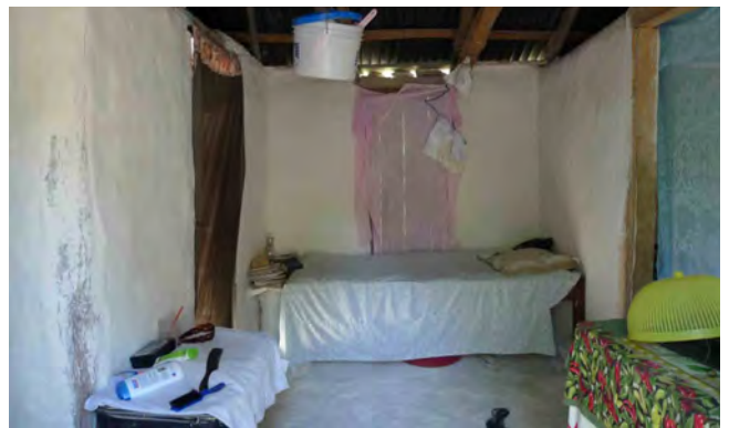
Les enduits faits avec le tuf blanc rendent l'intérieur des maisons très lumineux.
